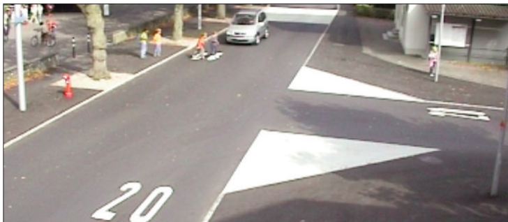
Nachher-Zustand 2008: Einmündung Freudenreichstrasse
