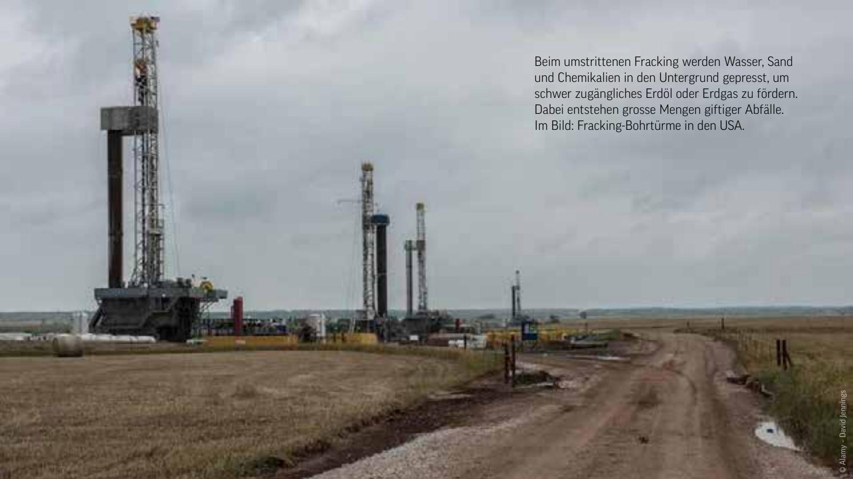
Beim umstrittenen Fracking werden Wasser, Sand und Chemikalien in den Untergrund gepresst, um schwer zugängliches Erdöl oder Erdgas zu fördern. Dabei entstehen grosse Mengen giftiger Abfälle. Im Bild: Fracking-Bohrtürme in den USA.
