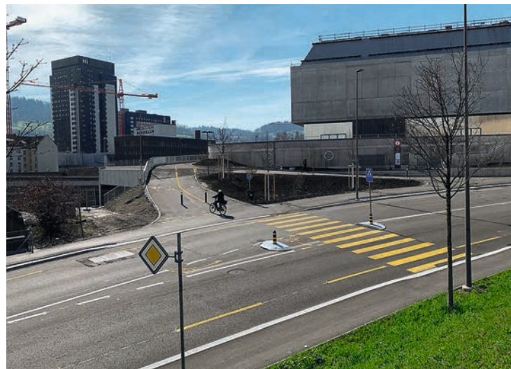
Ein Meilenstein: der neue Anschluss Splügenweg.
