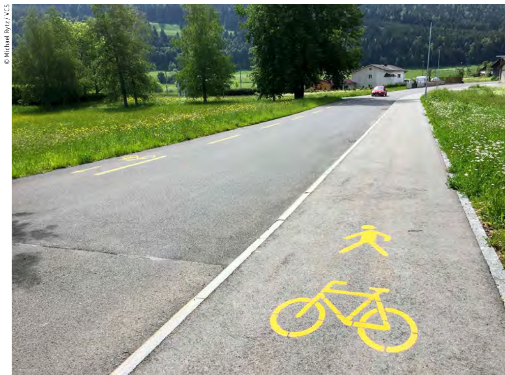
Wo es nicht möglich ist, den Platz für Velofahrende und Zu-Fuss-Gehende zu trennen, ist der gemischte Verkehr eine akzeptable Lösung – aber nur wenn nach klar definierten Kriterien.
