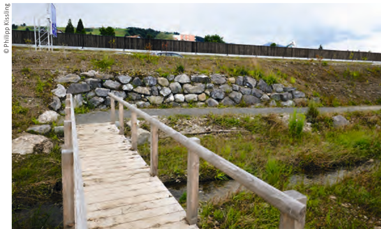
Die TZB und der umgelegte Weg mit dem hart erkämpften Wall.
