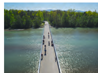
Radschnellverbindung Bregenz–Hard, Brücke über die Bregenzer Aach.
