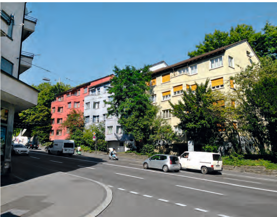
Diese Häuser bleiben dank dem Nein zum Rosengartentunnel bestehen.
