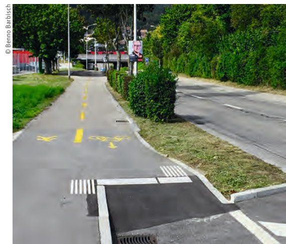
Biberist (SO): Ein Rampe, die sich mit dem Velo angenehm überfährt – gleich- zeitig können Sehbehinderte den Absatz dank der weissen Streifen ertasten (mehr zum Thema lesen Sie auf Seite 29).
