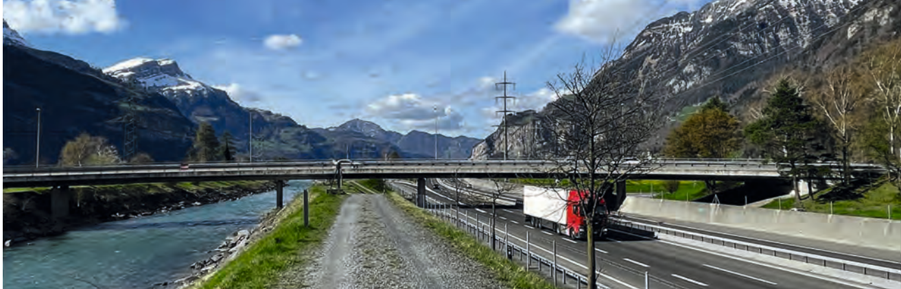
Auf der Reussbrücke sollen die heutigen Trottoirs zu einem Fuss- und Veloweg zusammengelegt werden – ohne Anpassung der Gesamtbreite.
