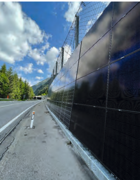
Pilotanlage an der A13 (Wandmauer Cozz)
