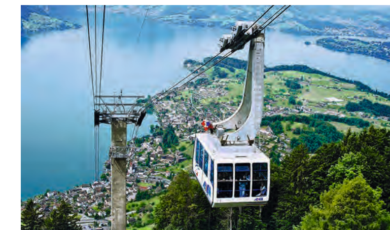
100 zusätzliche Parkplätze, aber kein ÖV-Anschluss der Talstation? Dazu darf es mit dem Ersatz der Pendelbahn von Weggis nach Rigi Kaltbad nicht kommen.
