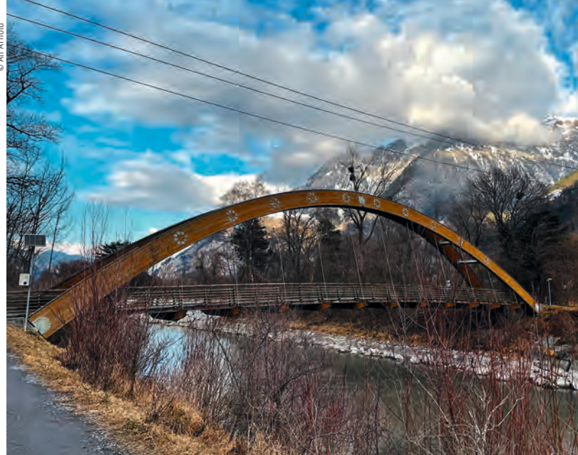
Eine Holzbrücke wie hier am Weg der Schweiz wäre eine gute Lösung für den Veloübergang nach Seedorf hinüber.
