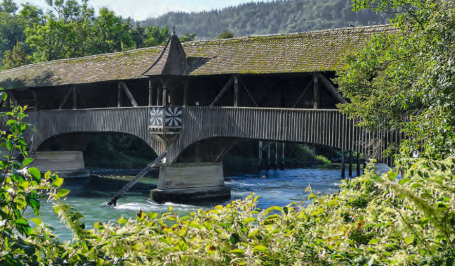
Die Holzbrücke von Turgi entstand 1921 und ersetzte die erste Brücke aus dem Jahr 1845.
